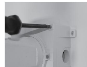
Затяните винты на кронштейне
